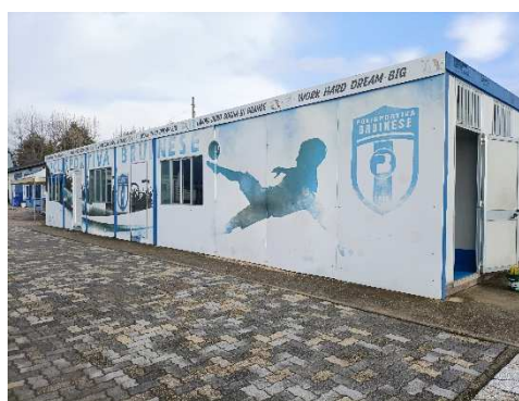
Foto 8: prefabbricato con uffici e bagni pubblici
